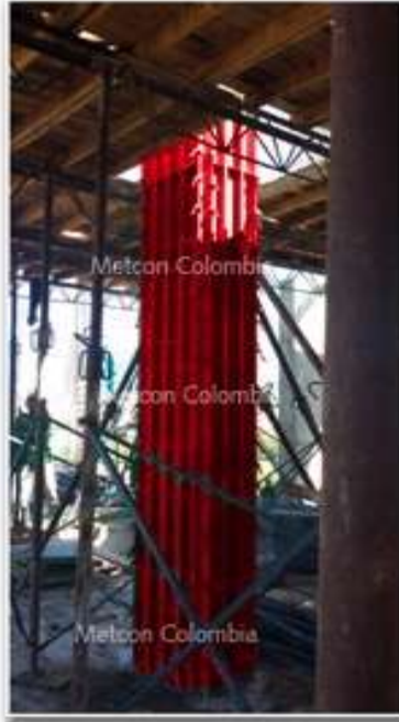
COLUMNAS Y LOSA
