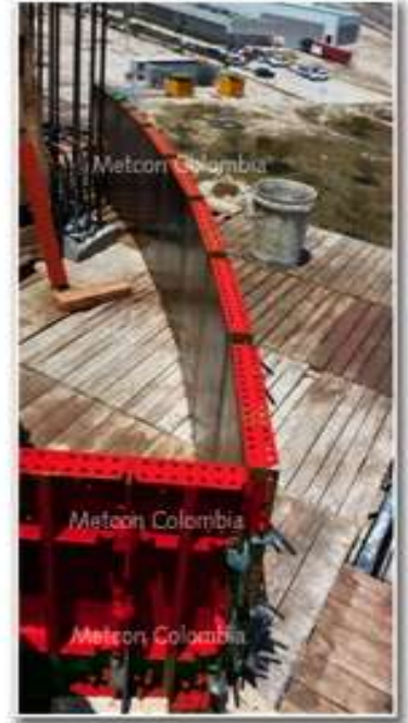
BORDE DE LOSA
