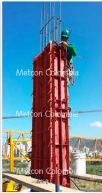
ARMADO DE COLUMNAS
